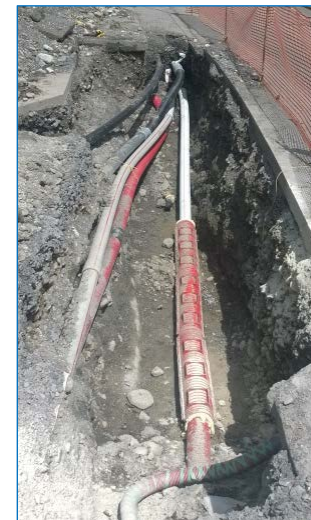
Remplacement du câble MT de 1965 et pose du nouveau câble FO pour relier les deux stations
